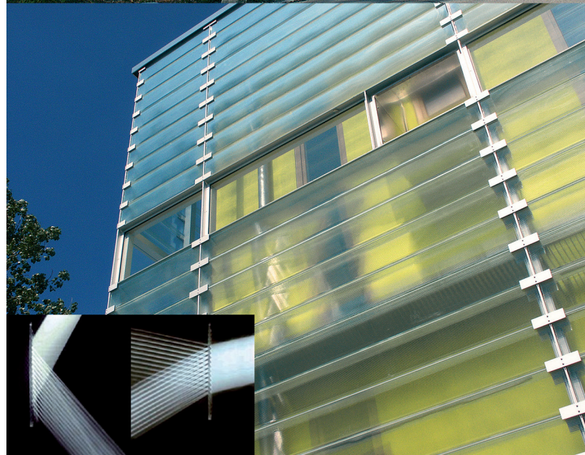
Фасад здания, остекленный в один ряд профилем Primasolar
