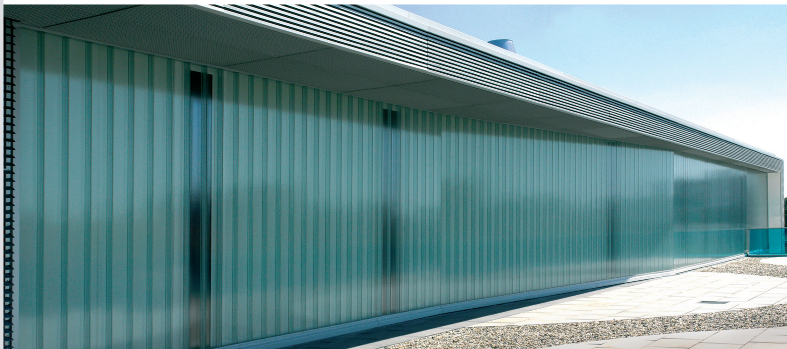
Фасады здания с полупрозрачным утеплителем
